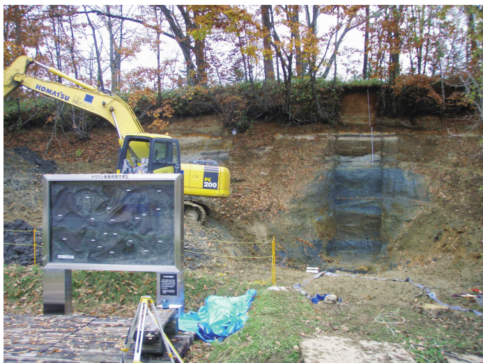
写真 2 : 2007年10月の調査位置
