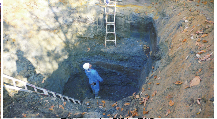
写真 3 : 2007年10月調査の掘削孔
