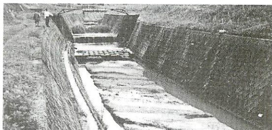
図31: 下流から見た松本の松本川河床のようす
